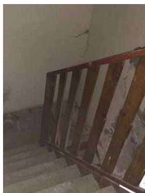
schodiště do 2.NP
